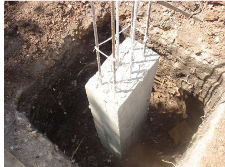
Hormigón armado (con armadura de acero)
